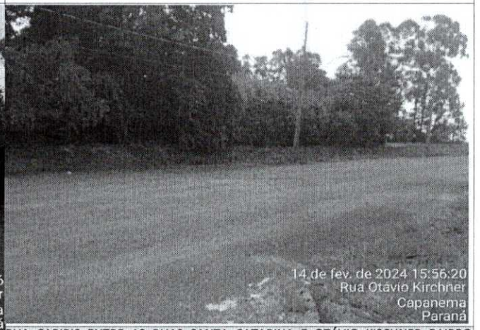
RUA CARIRIS ENTRE AS RUAS SANTA CATARINA E OTÁVIO KIRSCHNER BAIRRO SANTA BÁRBARA(PAVIMENTAÇÃO)
